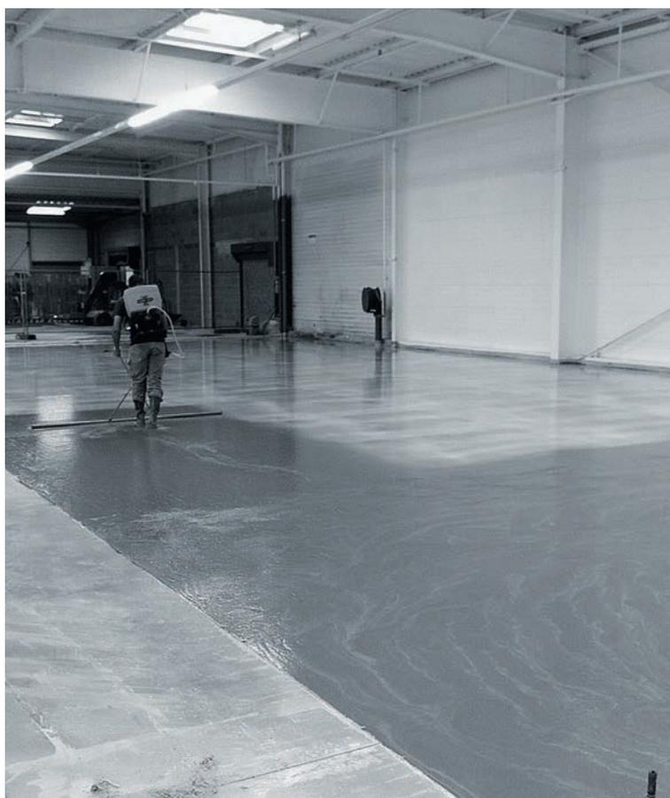
**Agilia CHAPE FORCE est une gamme de chapes fluides à base de ciment.** Elle permet de rattraper la planéité et/ou l'horizontalité des sols avant la pose du revêtement, tout en s'adaptant aux contraintes d'exploitation du local.
